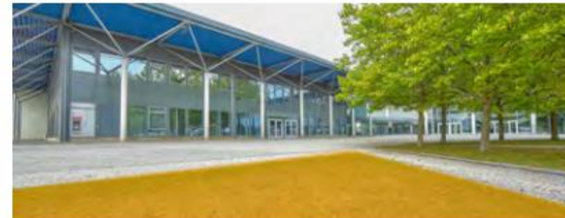
Abb. 2 – Rasenfläche gegenüber Geldautomaten
