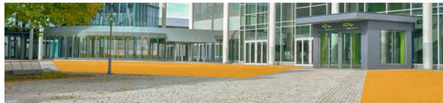
Abb. 3 – Flächen neben Eingang Halle 1
